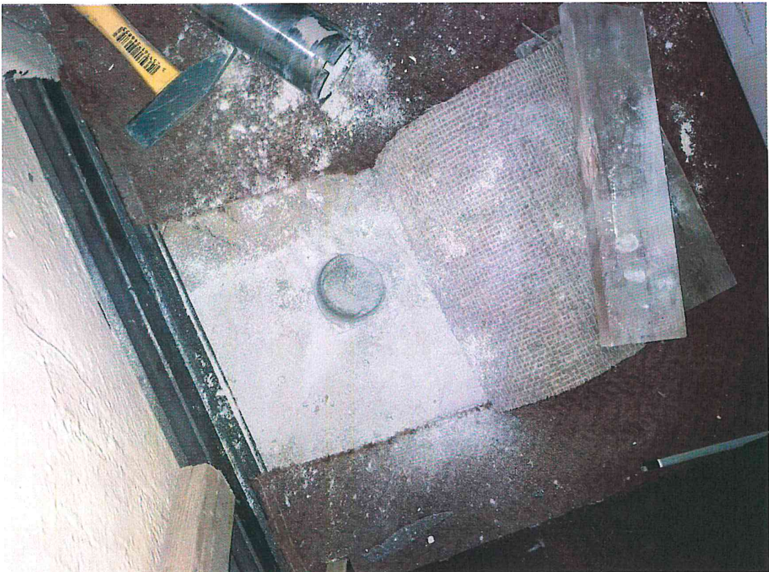
Fot. 3. Odkrywka nr 3 w pomieszczeniu na poziomie piwnicy
